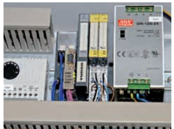
Die RFID-Daten werden über vier BL ident-Stationen von Turck per Profibus an die Datenbank geleitet
