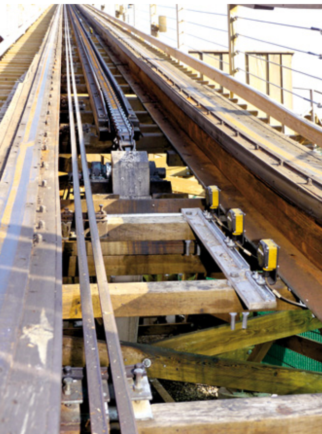
Über die gesamte Lifting-Phase wird die Bahn von den uprox+ Sensoren erfasst
