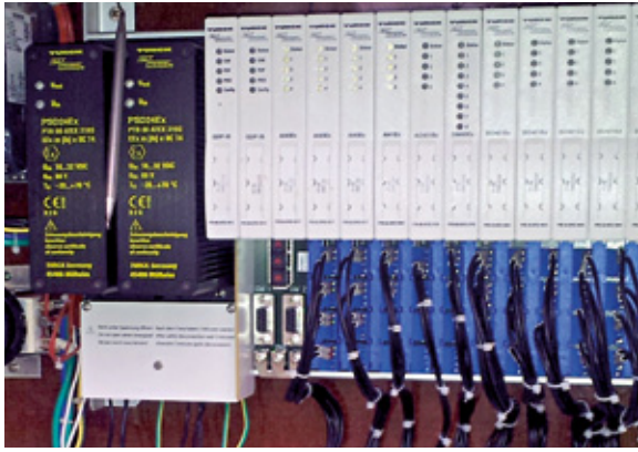
Weitere Module lassen sich an der excom-Station ergänzen, falls Feldgeräte nachgerüstet werden sollen
